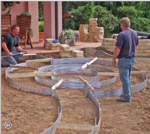
Ausrichten der Rasenkanten Elemente!
