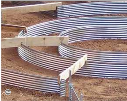
Provisorisch vorgesteckte Kanten!
