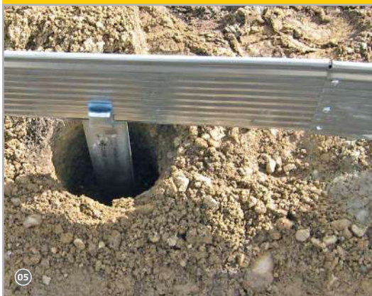
Eingegrabene Rasenkanten Bodenanker!
