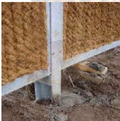
Nachdem aushärten des Betons, werden die Elemente mittig von oben zwischen den Flanschen der Pfosten eingelassen. Damit Sie an dieser Stelle der Montage keine Probleme bekommen, ist es sehr wichtig den Pfostenachsabstand beim betonieren exakt einzuhalten. Um die eingefädelt Elemente zu fixieren befestigen Sie diese mit den ersten zwei selbst schneidenden Schrauben.
