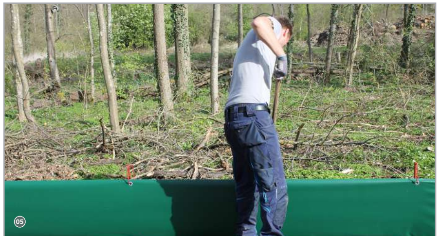
Montage eines Krötenschutzzauns!
