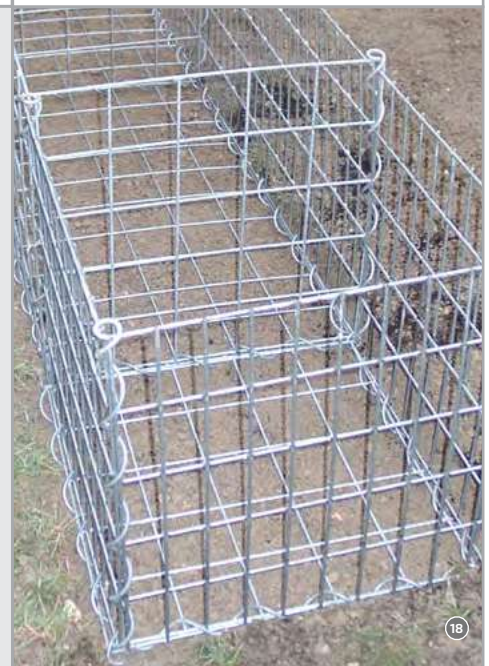
Abb. 9 Verbundener Gabionenkorb ohne Deckel!
