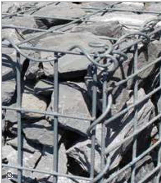
Fertig befüllte Spiralgabione!
