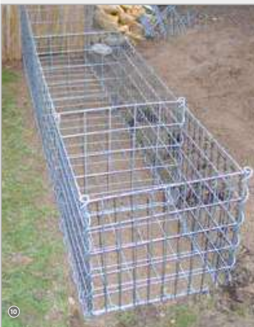
Spiralgabionen Grundgerüst!
