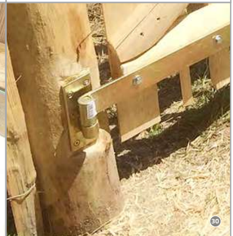
Abb. 19 Torriegel befestigen!
