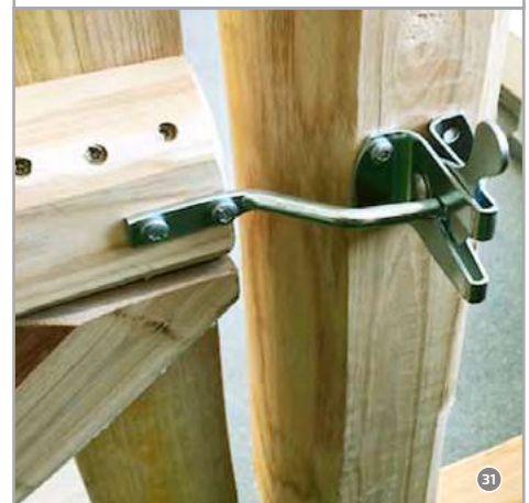
Abb. 19 Torriegel befestigen!
