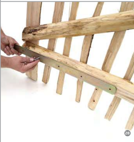
Abb. 16 Ausmessen der Befestigungslöcher!
