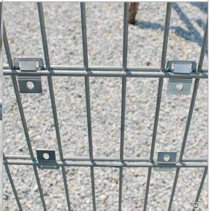
Abb. 14 Fertig installierte Vertikalclips!
